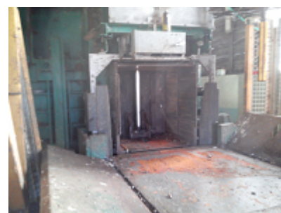
Vue d'ensemble de la presse
