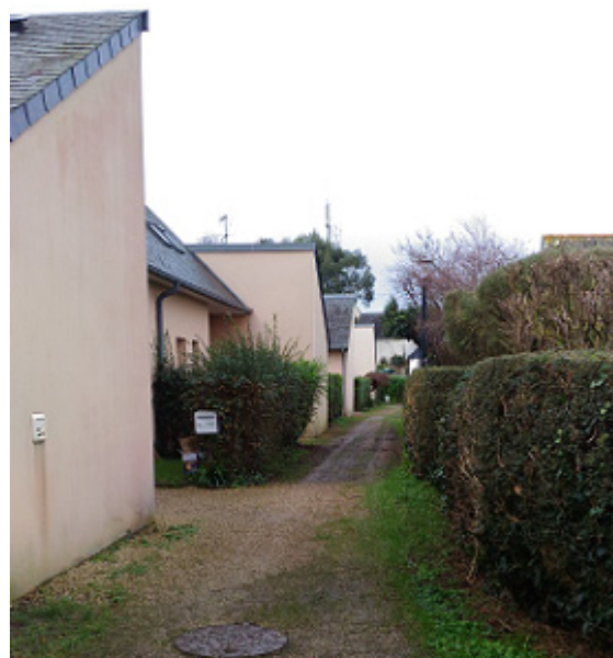
Les logements sociaux du chemin vert
