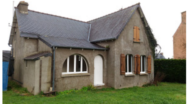
L'ancienne gendarmerie qui doit être détruite et remplacée par quatre pavillons pour loger de nouveaux résidents permanents. L'opération est faite par Côtes d'Armor Habitat en relation avec la commune
